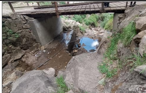
FIGURA N°02: Quebrada que pasa por debajo de un puente peatonal de madera, mostrando un cauce con material de arrastre y un punto de obstrucción.
