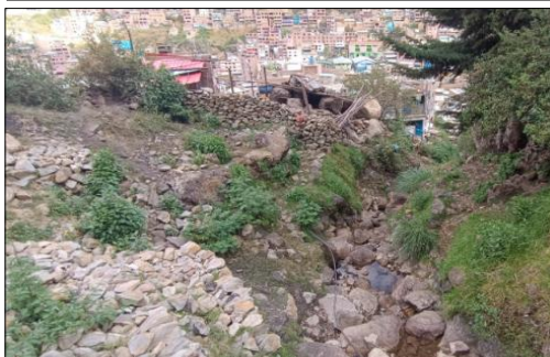
FIGURA N°03: Vista panorámica del cauce de la quebrada en una zona poblada, con márgenes inestables y la presencia de viviendas en las laderas adyacentes.
